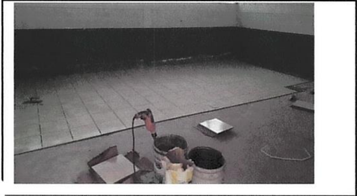
Foto1: Colocación de piso cerámico en el aula.
