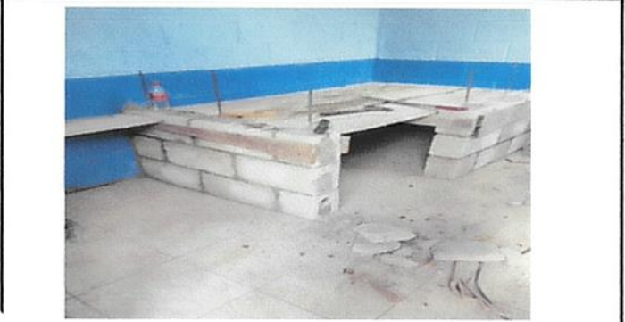
Foto 7: Reconstrucción de Poyeton con su respectiva plancha y chimenea
