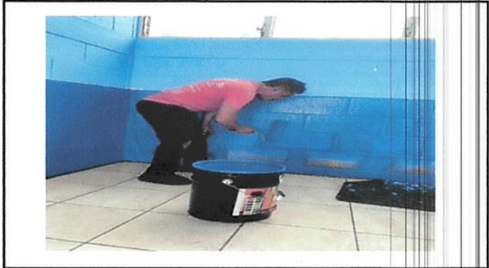
Foto 2: Colocación de pintura de aula y baños en interior y exterior.
