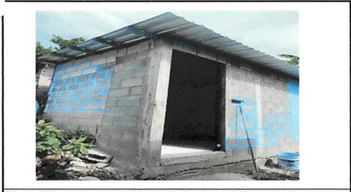
Foto 5: Mejoramiento de bodega existente (instalación de estructura metálica, lámina troquelada calibre 26, piso y puerta).
